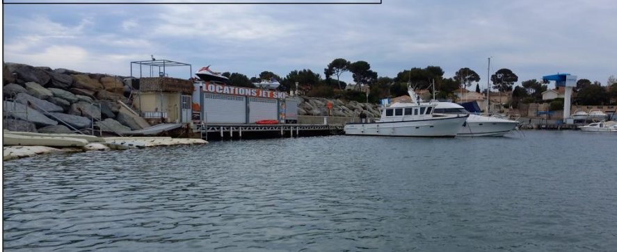
Prise de vue zone 4 et 5 – Extrémité du musoir digue sud
