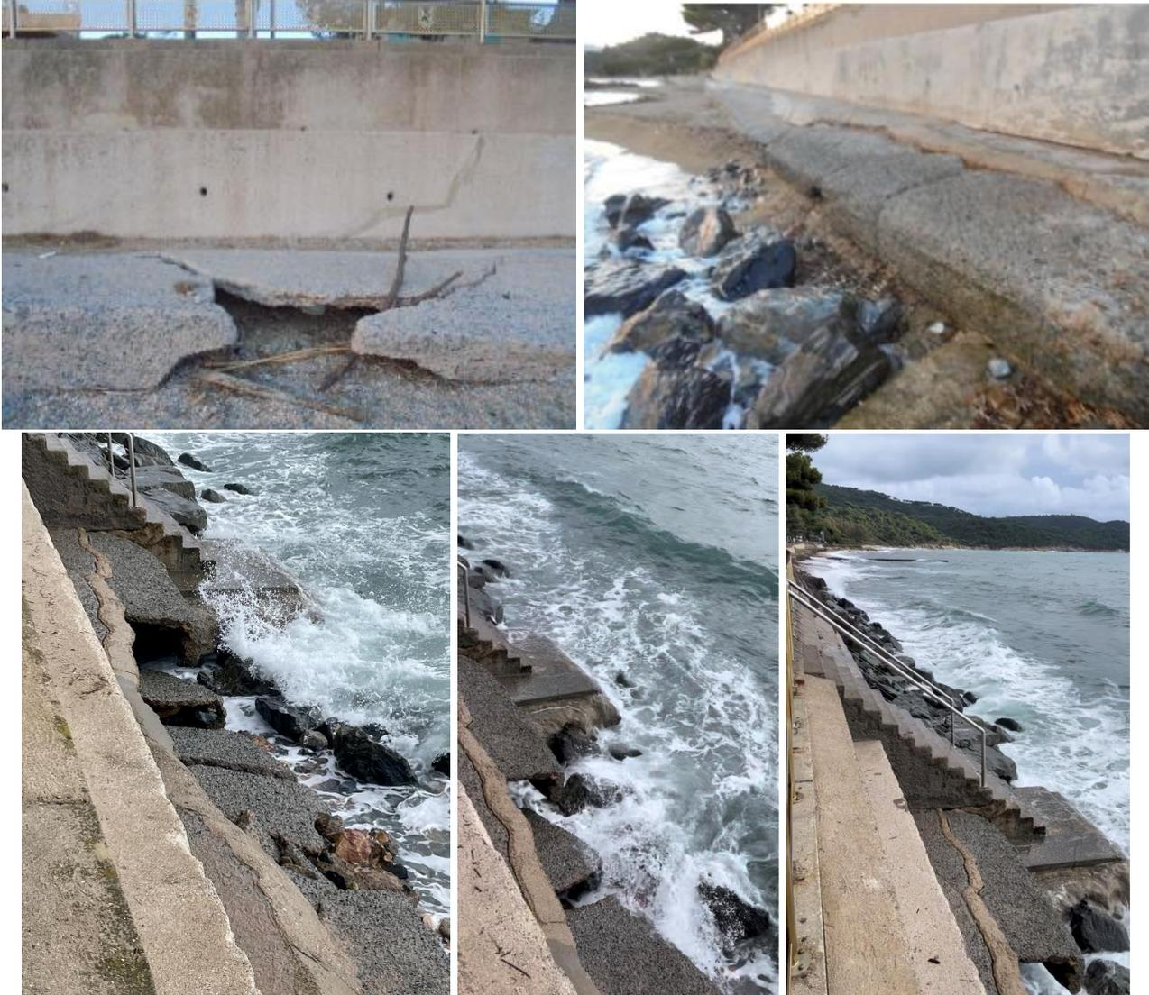
Figure 7 Destruction des l'assise du mur de soutènement
