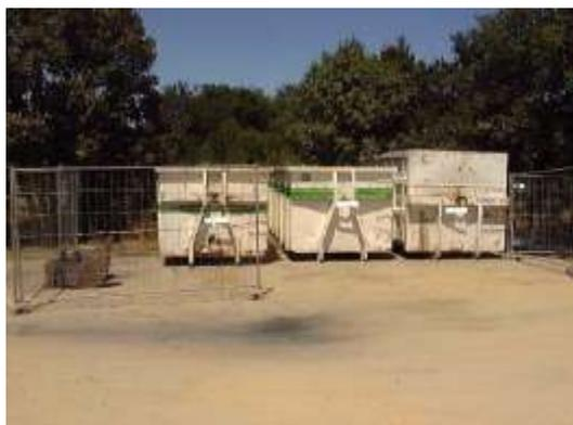
Figure 64 : Exemple de bennes destinées à accueillir les déchets de chantier
