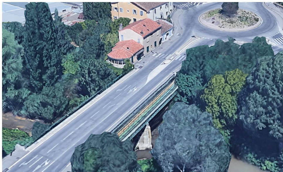
Figure 1-14 : vue de l'ouvrage existant – Source : google earth
