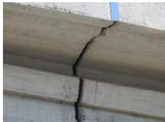
Figure 81 : Fissure présente sur le barrage
