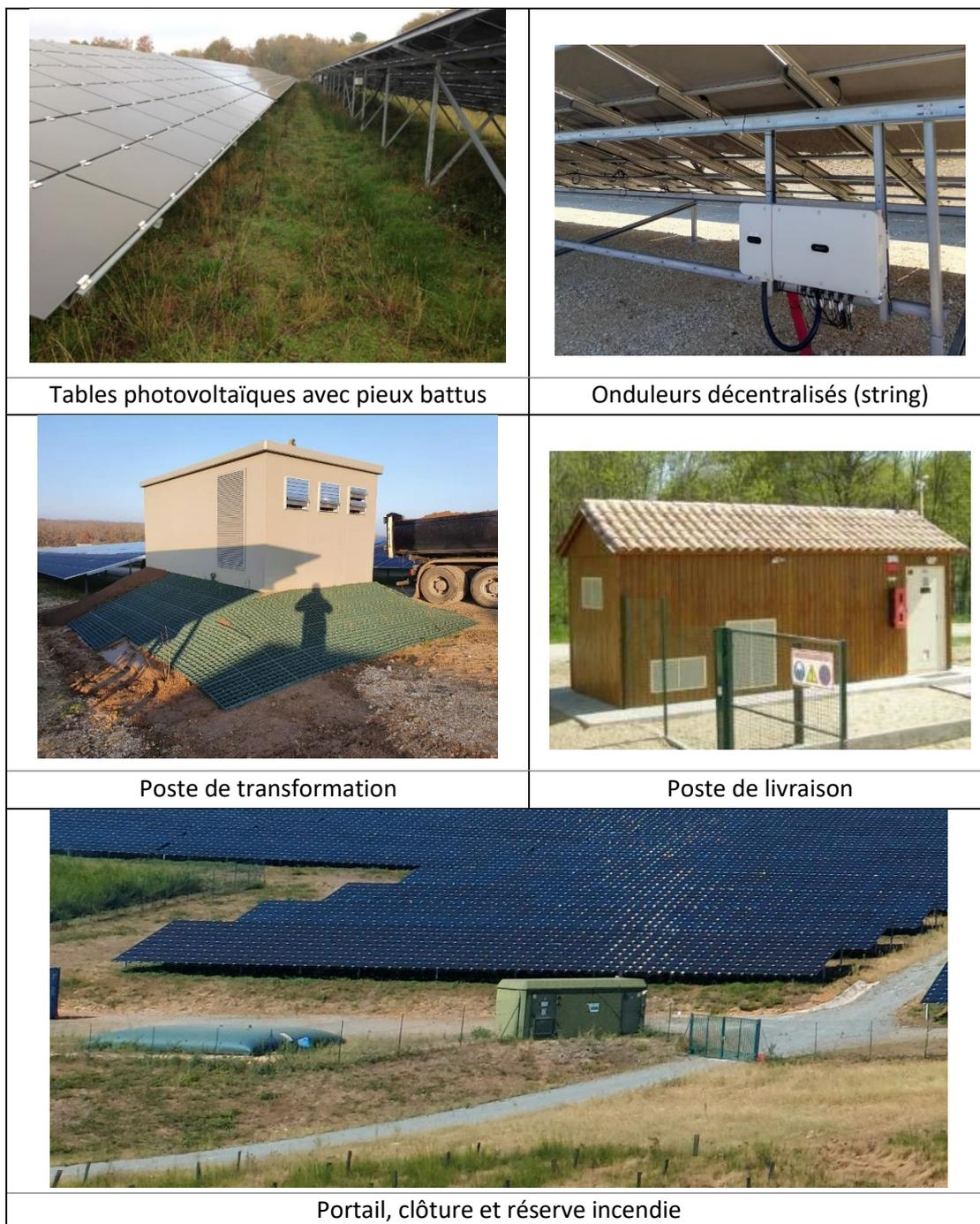
Figure 15 : Différents composants de la centrale solaire (source : JPee)
