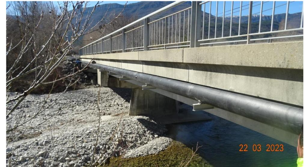
Figure 13 Exemple d'encorbellement de canalisation sur un ouvrage existant
