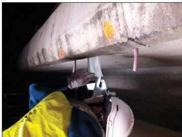
Vérification des SAR mis en place avant de les retirer
