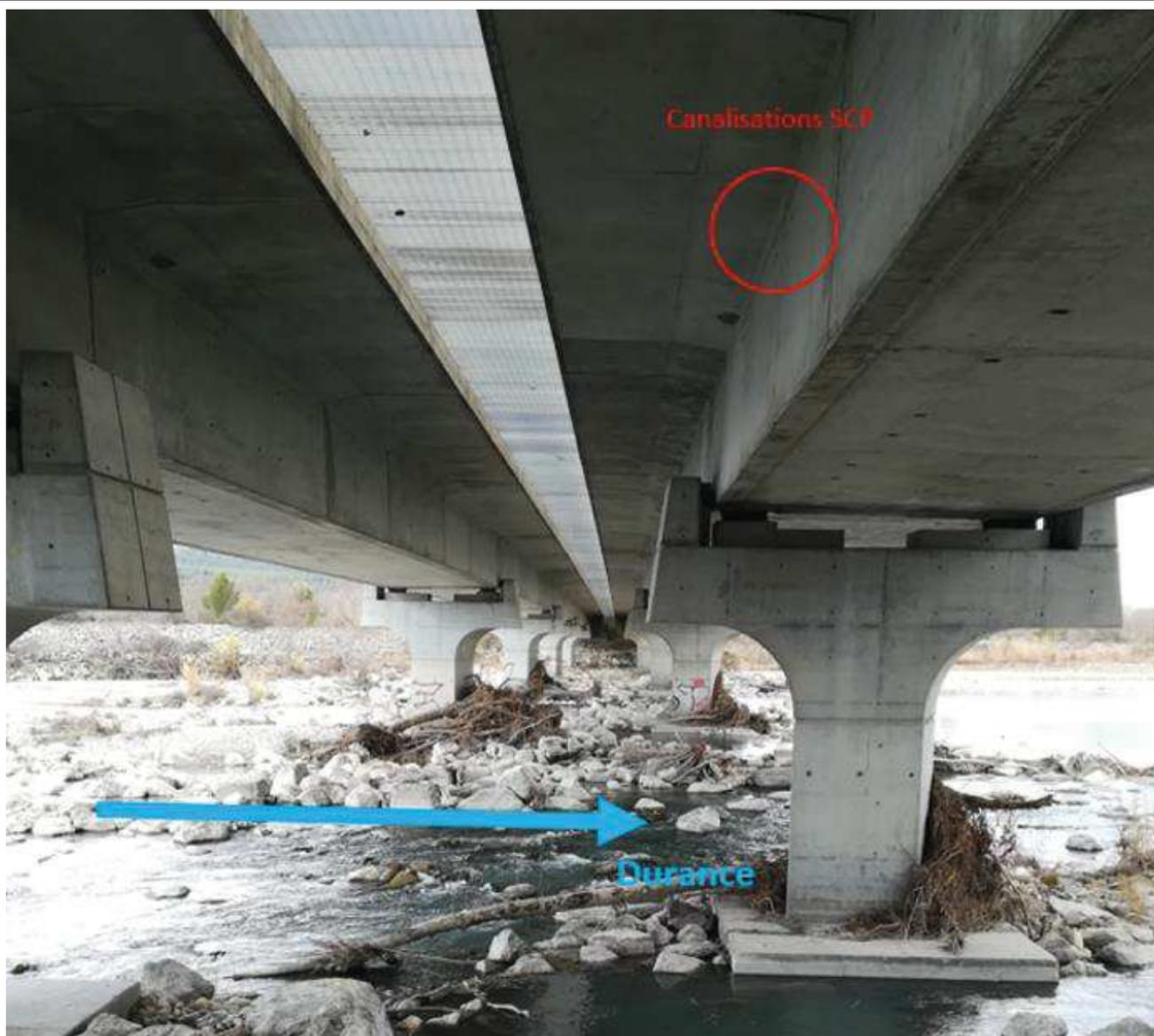
Figure 45. Implantation envisagée de la canalisation sous le pont
