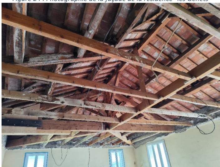
Figure 25 : Structure du toit de l'école vu dans la partie sud
