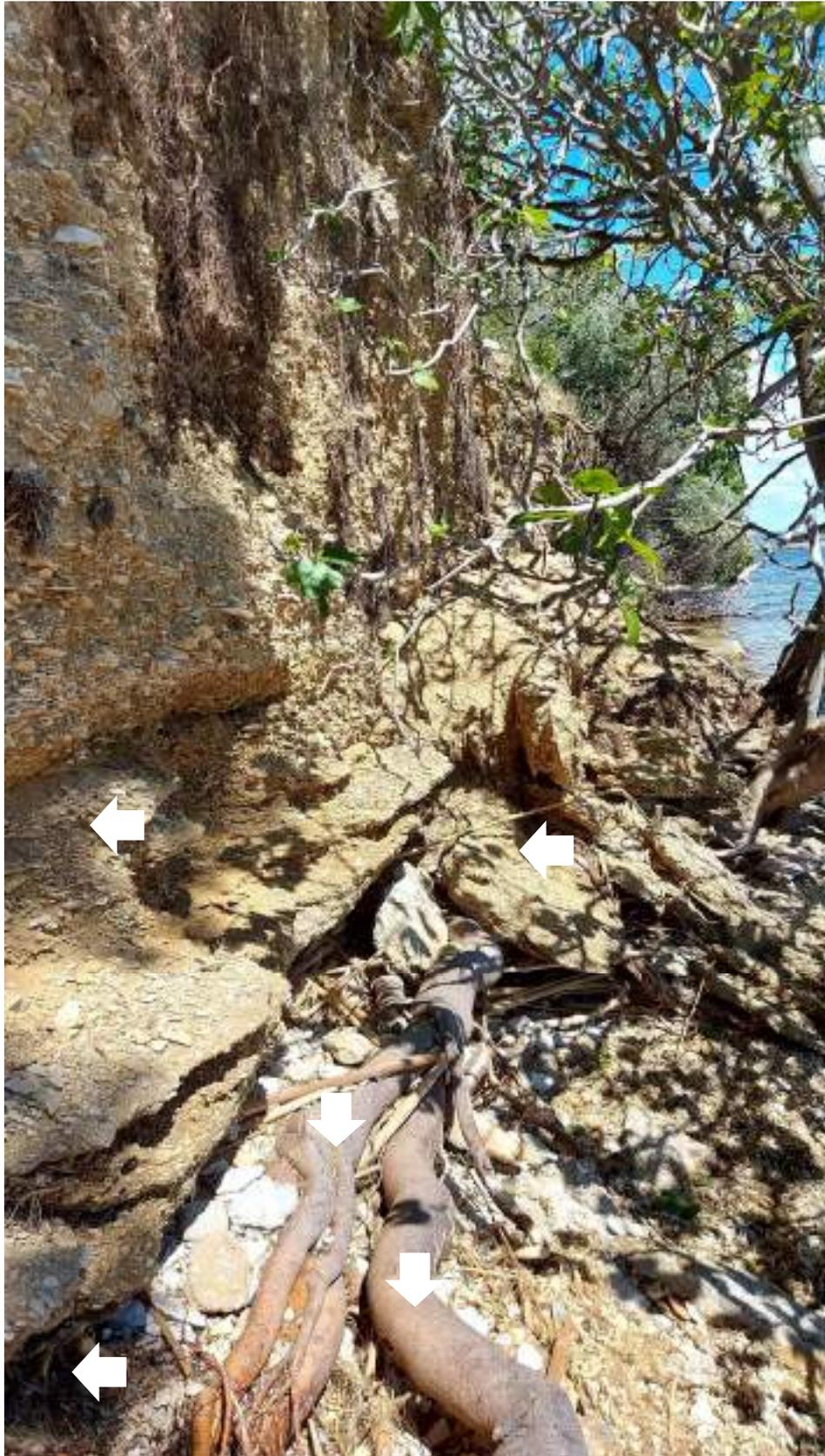
Les racines du pin apparaissent également très développées. Elles sont localisées de façon privilégiée en pied du talus et dans les horizons les plus perméables du matériau. Elles favorisent fortement la déstructuration du talus par sous-creusement et érosion différentielle.
