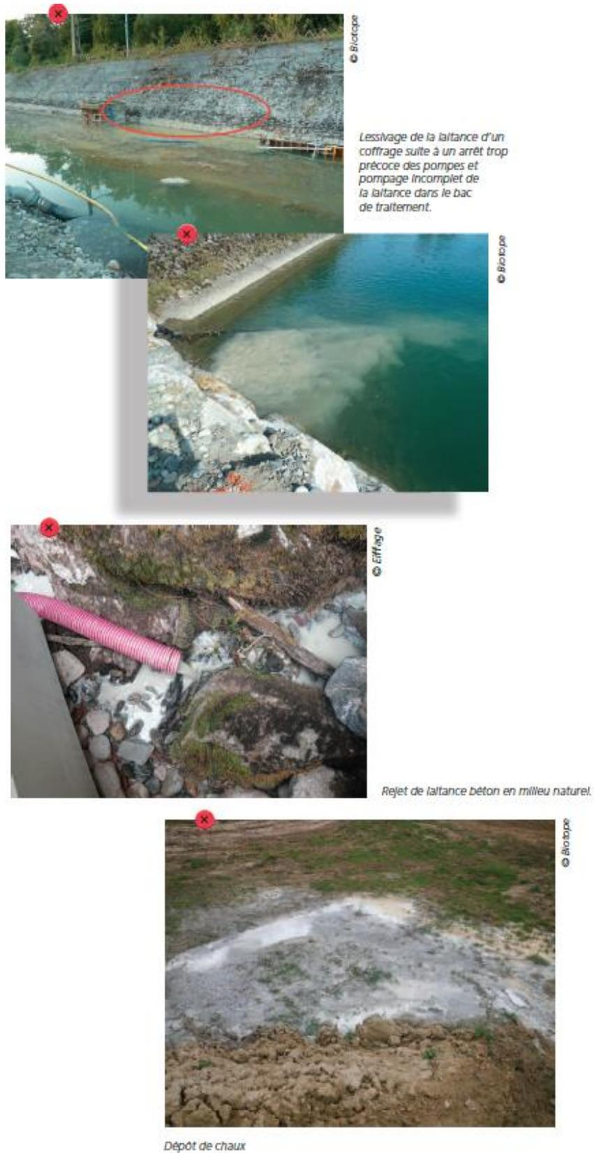
Figure 4 - Photographies de pollutions accidentelles des eaux dues à un chantier - Source : AFB guide de bonnes pratiques environnementales
