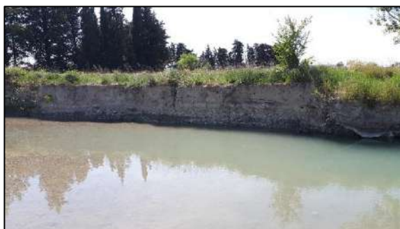
Zone de nidification du Guêpier d'Europe au sein de cavités creusées dans la berge érodée
