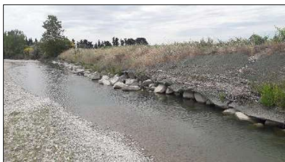
Enrochements de berge
