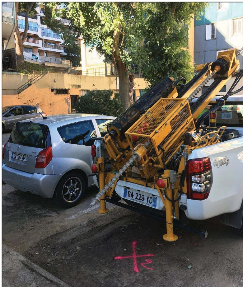
Figure 13 : Illustration des sondages réalisés
