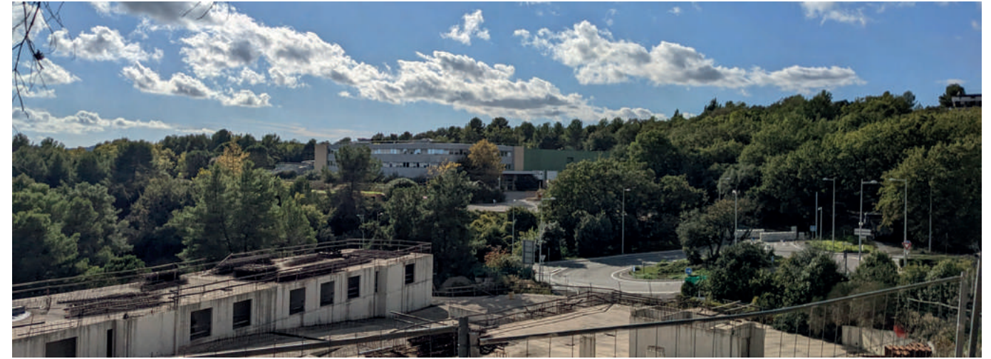
Vue depuis les Terrasses d'Antipolis.
