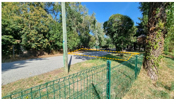
Figure 20 : Réhausse aval au niveau du skatepark
