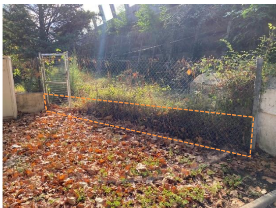
Figure 21 : Réhausse amont au niveau de la Chapelle
