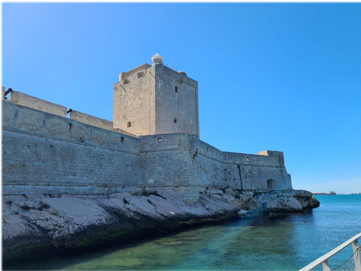
Photo 1 Situation après les traversées en direction du golfe, côté Martigues
