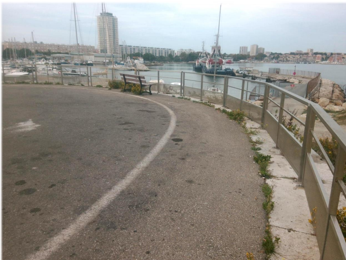
Photo 2 Situation avant les traversées en direction du port, côté Port-de-Bouc
