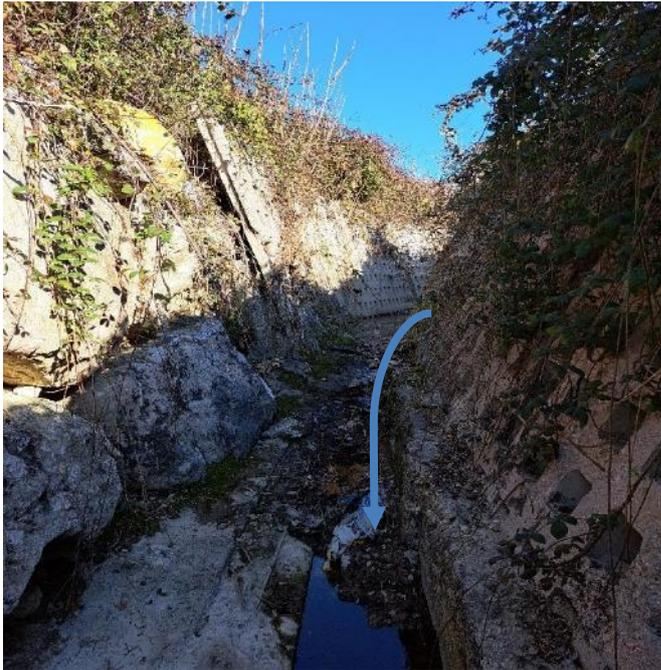
Le ravin des Dignerieux est construit en ouvrage de soutènement en béton alvéolaire sur 60ml en rive droite et 70ml en rive gauche depuis le pont de la route d'Orange.
