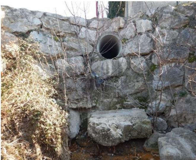
Le ruisseau de la Miaille qui représente aussi le réseau d'eau pluvial se jette dans la Petite Mayre via une buse en béton
