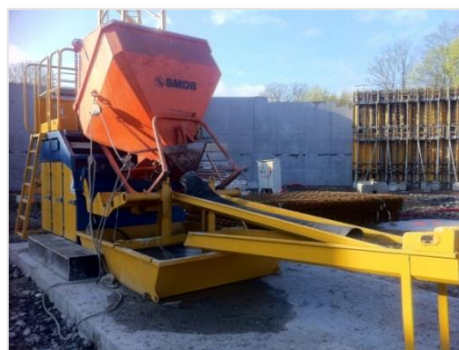
> Evacuation des déchets dangereux (DD) vers un centre de traitement spécialisé ; > Nettoyage des toupies à béton impératif en centrale ; > Mise en place de podium de nettoyage de la benne à béton :
