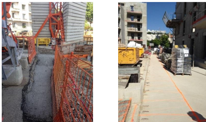
Figure 1: Pratiques vues sur nos chantiers (cheminement piétons)
