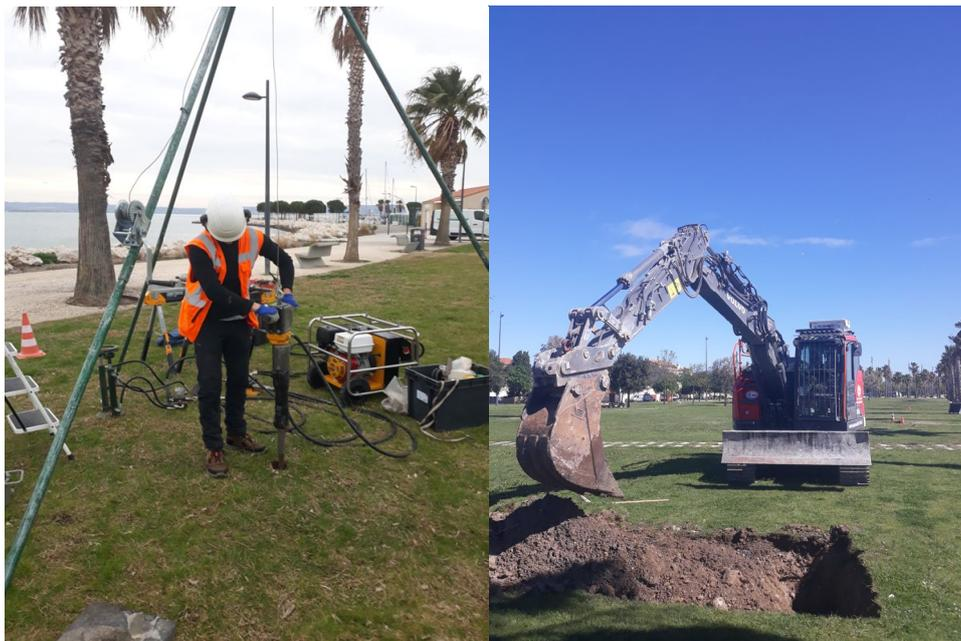
Figure 25 : Matériel utilisé pour la réalisation des sondages et des fouilles
