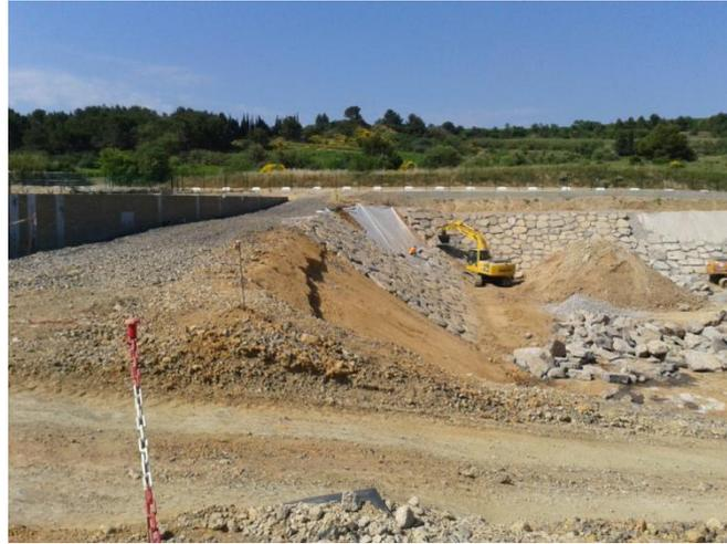
**Schéma 10 : Exemple de mise en œuvre d'un enrochement drainant.**
