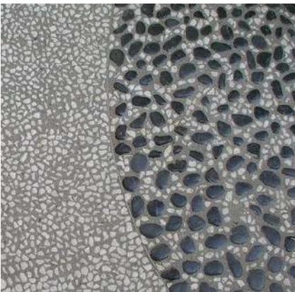
Béton désactive Espace public
