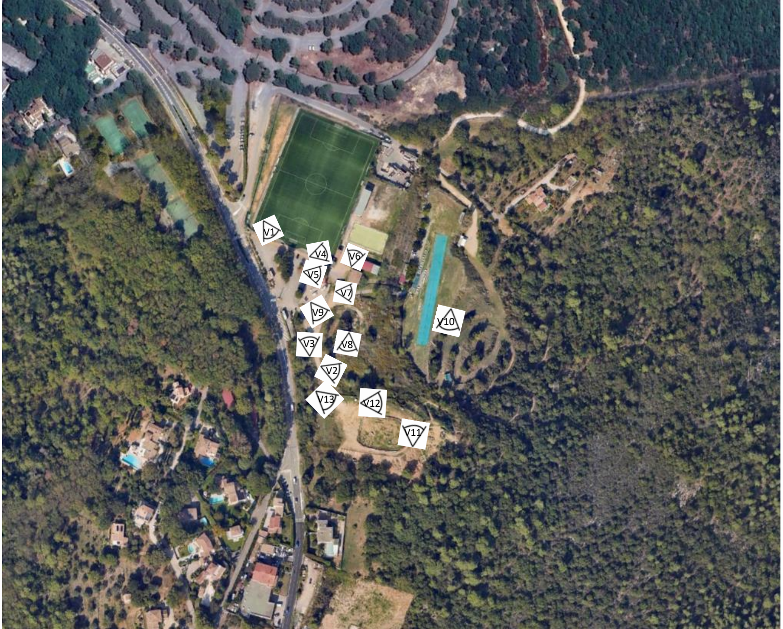
Vue aérienne de l'existant – Repérage des positions de prise de vue des photographies
