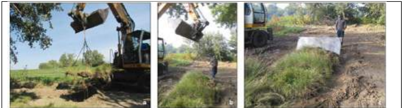
(a) transport de la plaque métallique; (b) dépôt au sol sur sol préparé; (c) glissement de la plaque de sol à terre.
