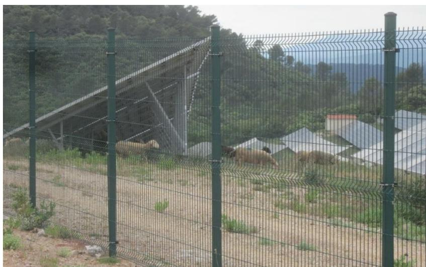
Exemple de poteaux bouchés par des bouchons en plastique
