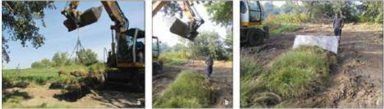
(a)transport de la plaque métallique; (b) dépôt au sol sur sol préparé; (c)glissement de la plaque de sol à terre.
