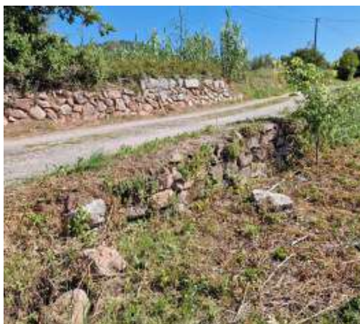
Murets en pierres sèches
