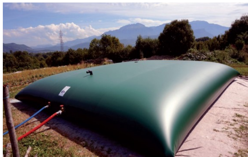
Figure 17 : Exemple de citerne incendie
