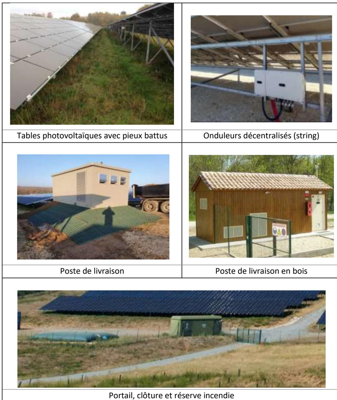
Figure 13 : Différents composants de la centrale solaire
