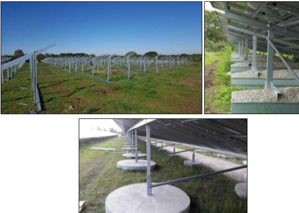
Figure 15 : Mise en place des structures sur pieux battus (centrale JPee de Braïze, 03), structures en bac acier (centrale JPee de Questembert, 56) et structures en longrines béton (centrale JPee de Labarde, 33)
