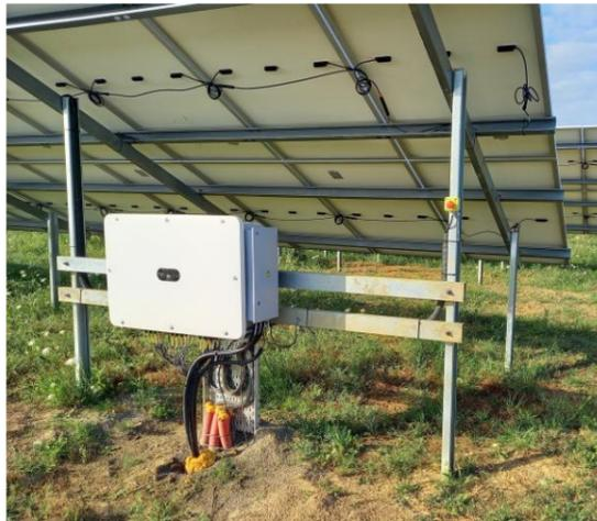
Figure 15 - Exemple d'onduleur
