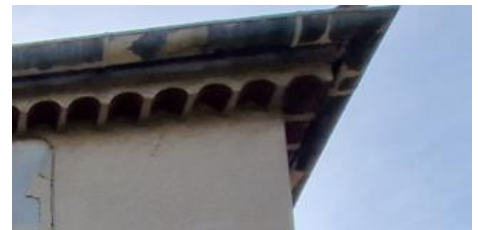
Photo 12: Interstice sous toiture
