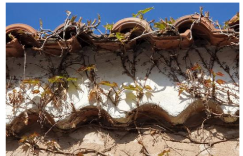
Photo 2: Interstice sous toiture
