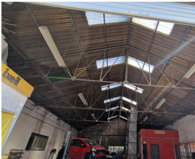
Photo 17: Intérieur du garage
