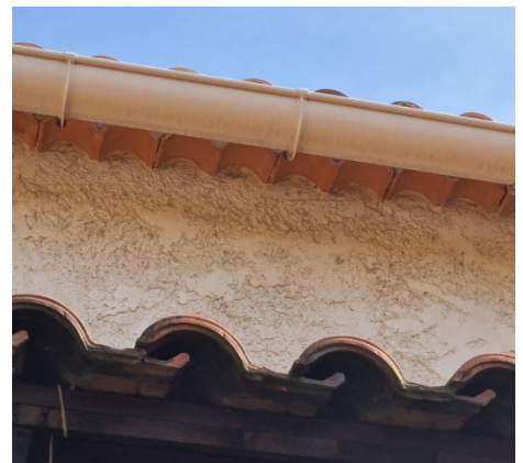
Photo 9: Interstice sous toiture
