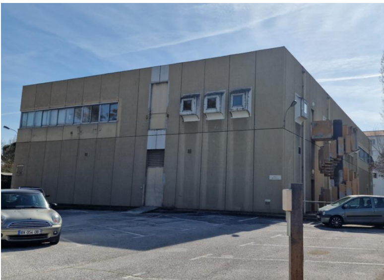
Photo 21: Bâtiment Orange télécoms
