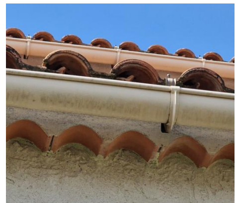
Photo 5: Interstice sous toiture
