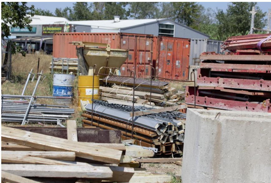
Stockage de matériaux de construction sur la friche
