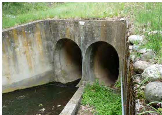
Entrée de l'ouvrage n°43 © LPO PACA
