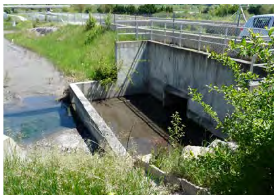
Ouvrage n°5, en amont © LPO PACA
