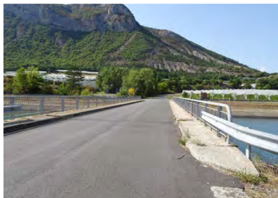
Pont routier sur le canal EDF n°21 © LPO PACA
