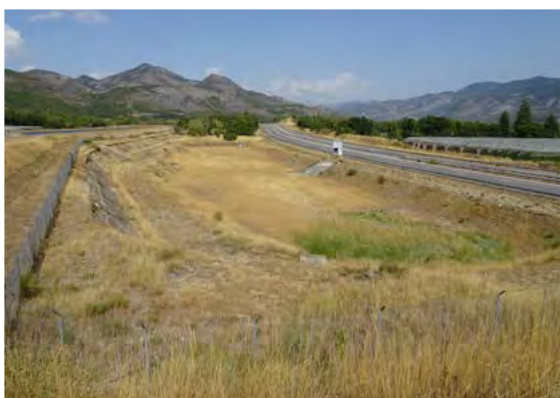
Bassin de rétention en aval de l'ouvrage n°21 © LPO PACA
