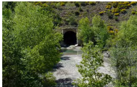
Ouvrage n°37 aval © LPO PACA
