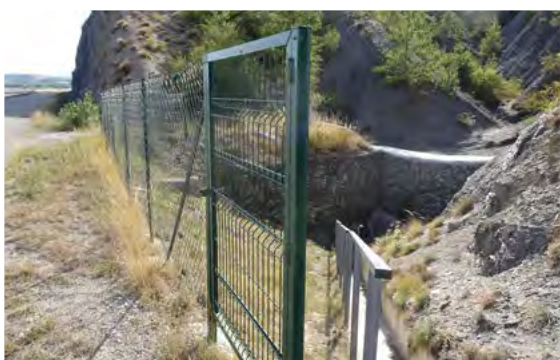
Ouvrage n°41 amont © LPO PACA
