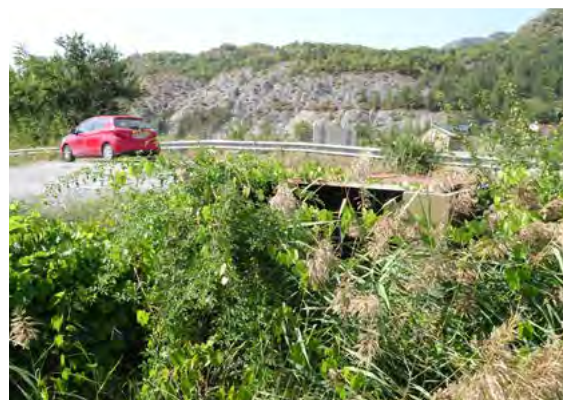
Ouvrage n°5, en aval © LPO PACA
