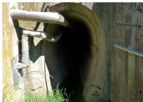
Ouvrage n°38 amont © LPO PACA
