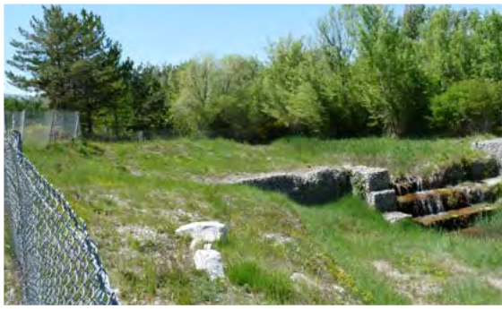
Amont de l'ouvrage n°35 grillage à aménager afin qu'il devienne franchissable par la petite faune © LPO PACA
