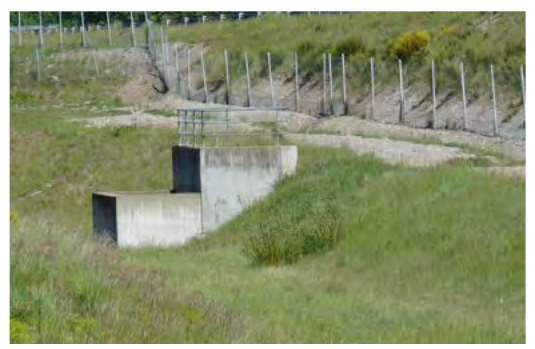
Ouvrage n°6, non visitable © LPO PACA
