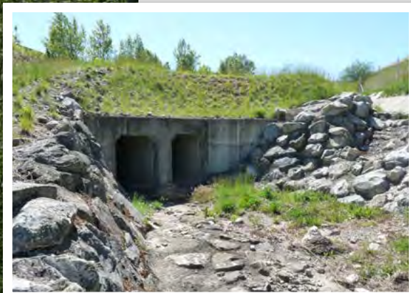
Ouvrage n°7, en amont © LPO PACA
