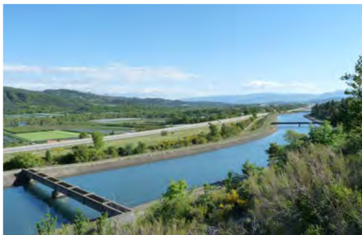
Ouvrages n°24 à 26 © LPO PACA
