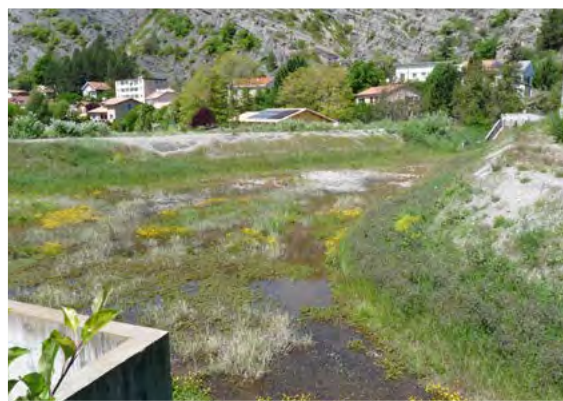
Ouvrages n°4, bassin de rétention © LPO PACA
