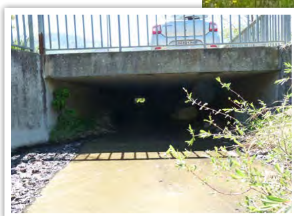
Ouvrage n°1, en aval © LPO PACA
