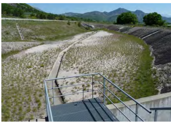
Bassin de rétention en amont de l'ouvrage n°29 © LPO PACA
