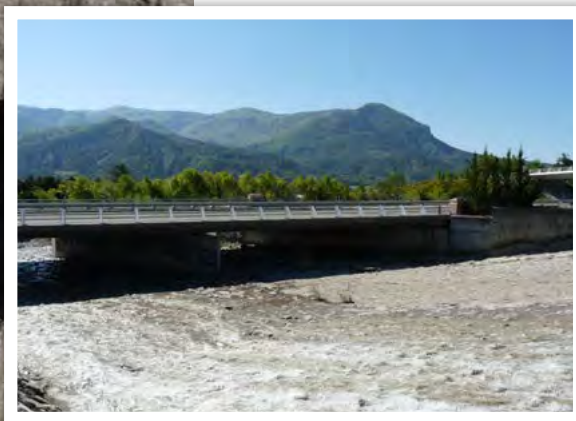
Ouvrage n°19 vu de l'amont © LPO PACA
