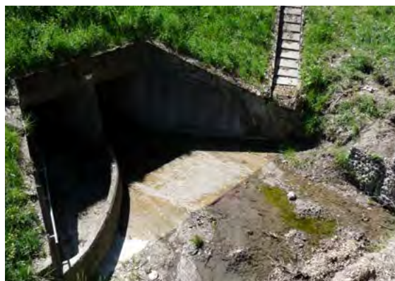
Ouvrage n°28 en amont © LPO PACA
