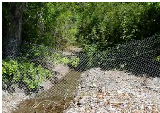
Torrent de la Pisse grillage à aménager © LPO PACA
