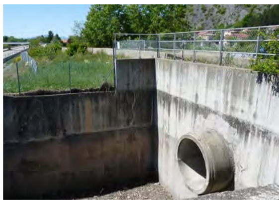
Ouvrages n°4, bassin béton © LPO PACA
