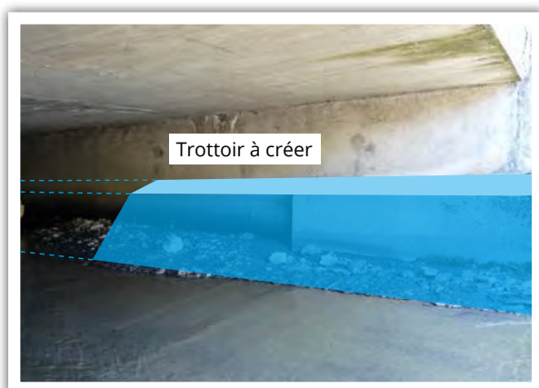
Ouvrage n°1, trottoir à créer © LPO PACA
