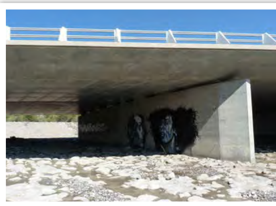
Ouvrage n°19 vu de l'aval © LPO PACA
