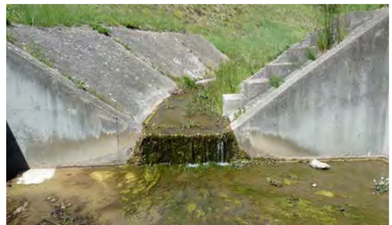
Ouvrage n°36 canal Ouest Seuil à supprimer © LPO PACA
