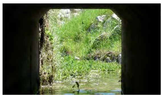
Aval de l'ouvrage n°36 à aménager afin qu'il soit hors d'eau © LPO PACA
