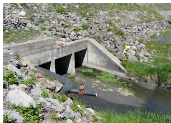
Ouvrage n°3, en aval © LPO PACA
