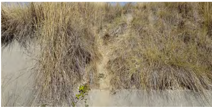
Trace de passage d'animaux en aval de l'ouvrage n°22 © LPO PACA
