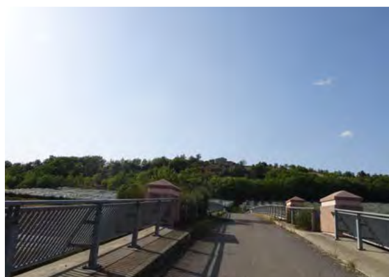
Ouvrage n°44 de traversée de l'A51 et de la RD 1085 © LPO PACA
