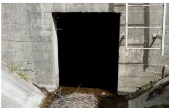
Ouvrage n°40 amont © LPO PACA
