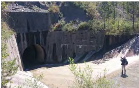
Ouvrage n°37 amont © LPO PACA
