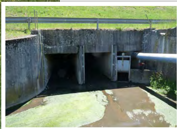
Ouvrage n°3, en amont © LPO PACA
