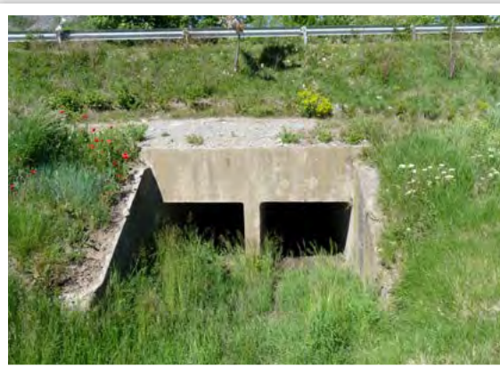
Ouvrage n°7, en aval © LPO PACA
