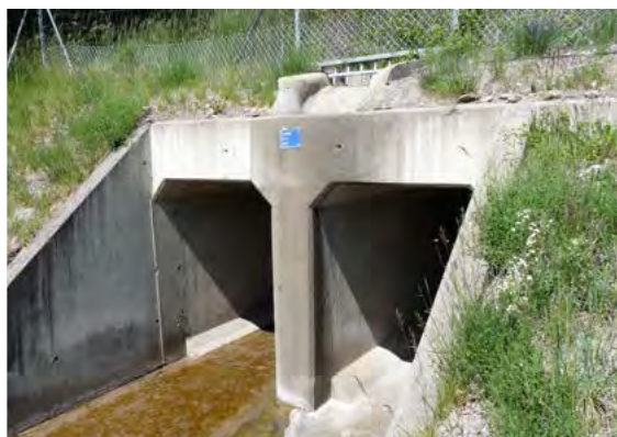
Ouvrage n°28 en aval © LPO PACA
