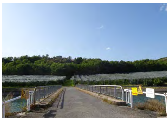
Ouvrage n°44 de traversée du canal EDF © LPO PACA
