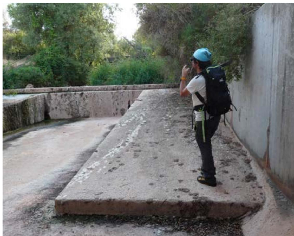
Rampes béton (ici un répartiteur) permettant à la faune de franchir aisément un seuil © Micaël GENDROT
