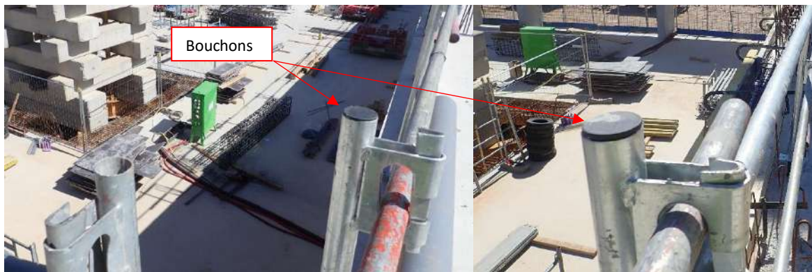
Figure 5 : Dispositifs d'obturation de poteaux creux (Agence MTDA)
