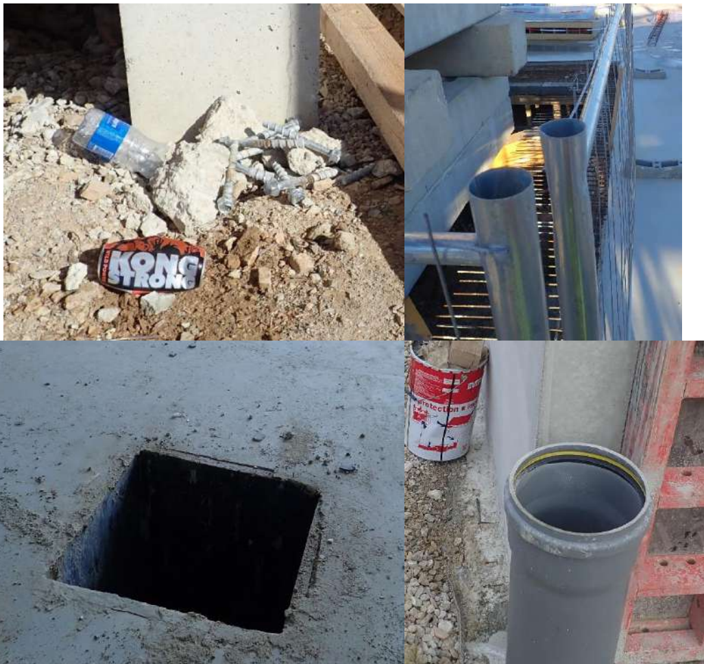
Figure 2 : Pièges artificiels pour la petite faune (Agence MTDA)
