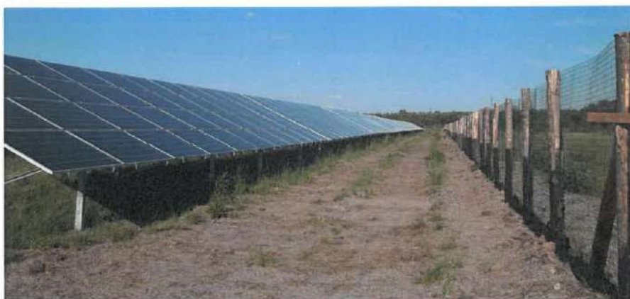
Figure 2 : exemple de clôture de type maille soudée souple fixée sur poteaux en bois
