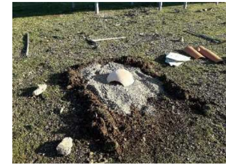
Pose de sable et d'une tuile dans le surcreusement servant d'abri hors gel
