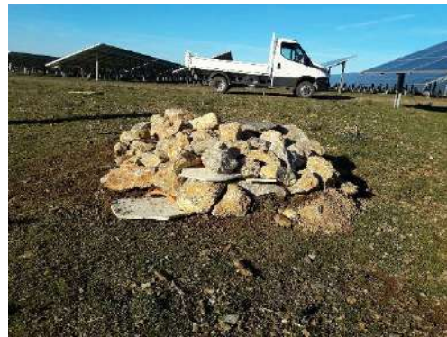
Mise en place de pierres J. JALABERT, 12/02/2019, Villanières (11)
