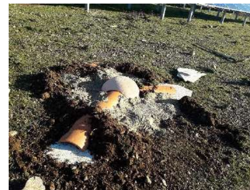
Pose des passages en tuiles
