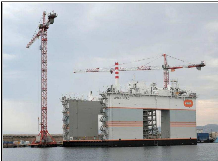
**Fabrication des caissons en béton sur le Grand Port Maritime de Marseille avec des matériaux provenant de la carrière de l'Estaque via l'A55.**
