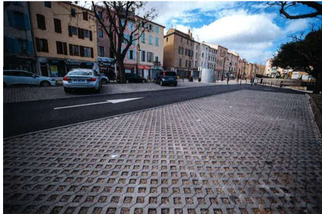
Aménagement du parking du Bourg à Narbonne
