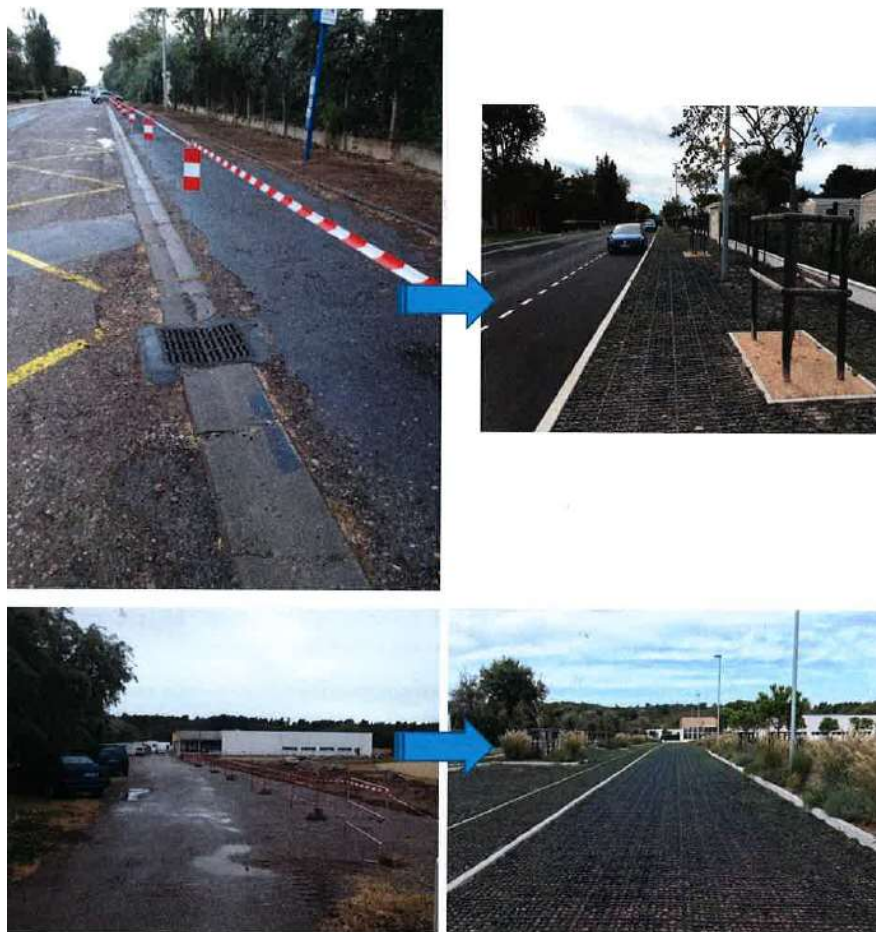
Aménagement de l'espace Baudis à Narbonne Plage, 2021
