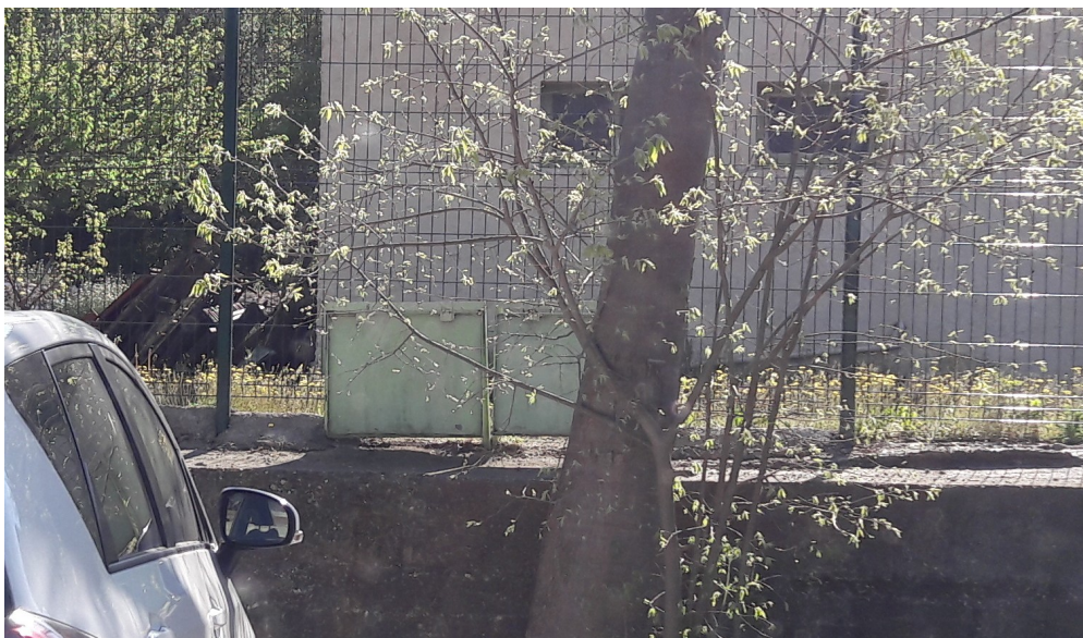
Illustration 6: Exemple de mesure mise en place par un particulier : des volets peuvent pivoter pour laisser passer les eaux
