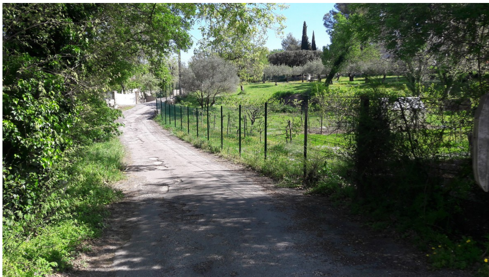
Illustration 4: Le talweg a ici renversé la clôture qui a été totalement reconstruite
